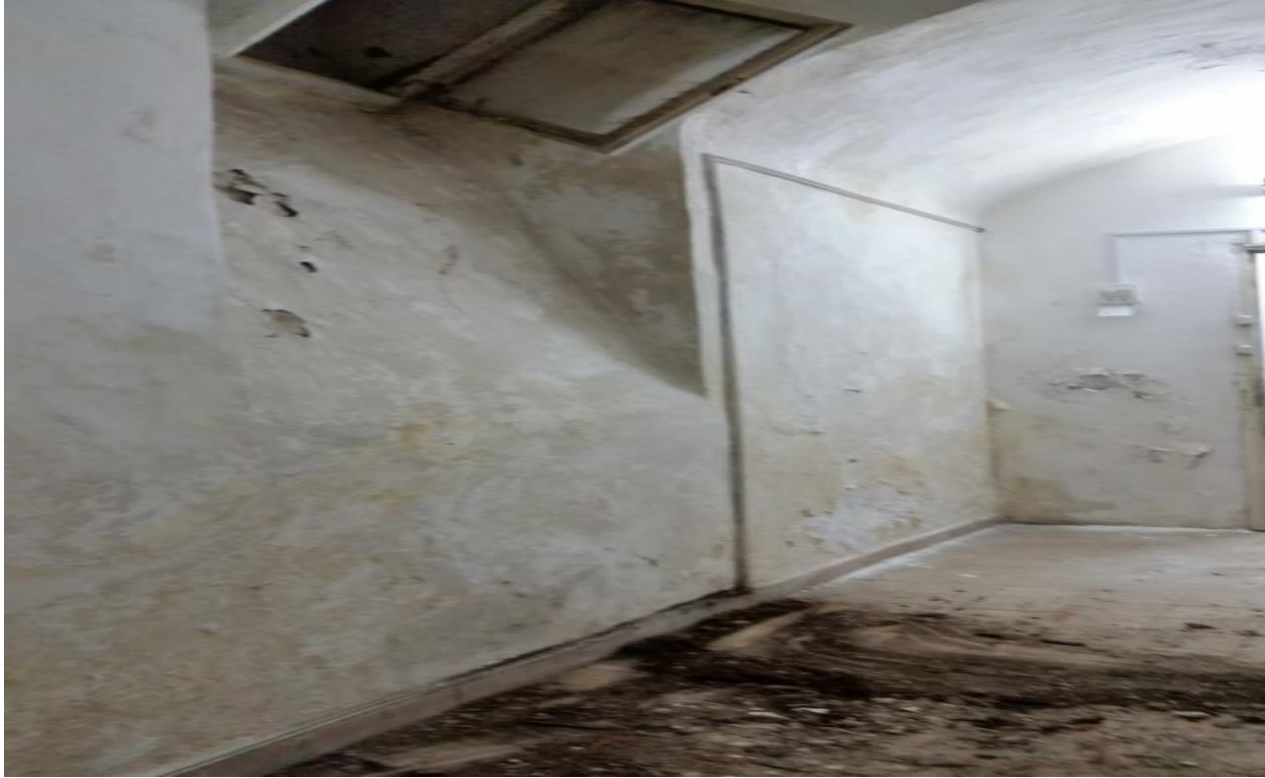
Inainte de interventie
